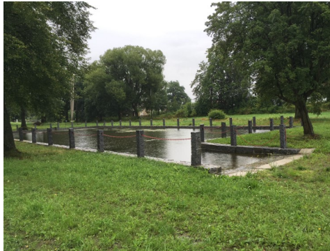
Požární nádrž Lučkovice
